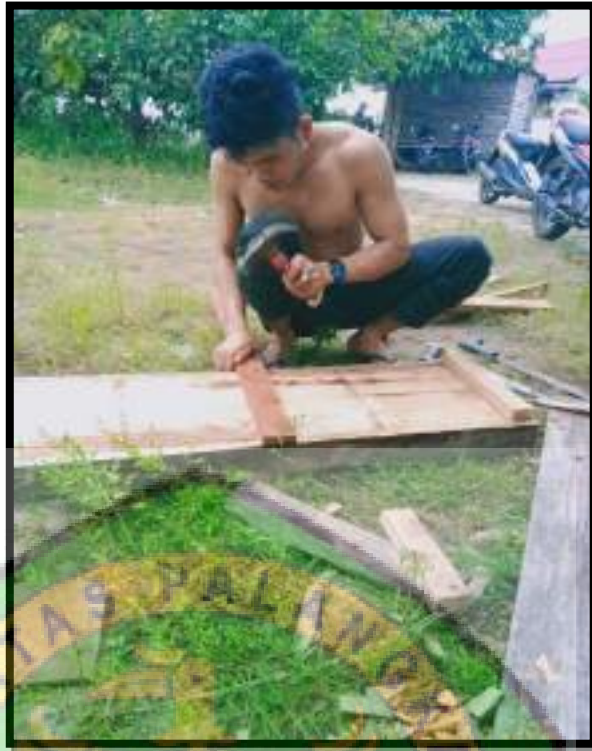
Gambar 10 Proses perakitan papan dan balok
